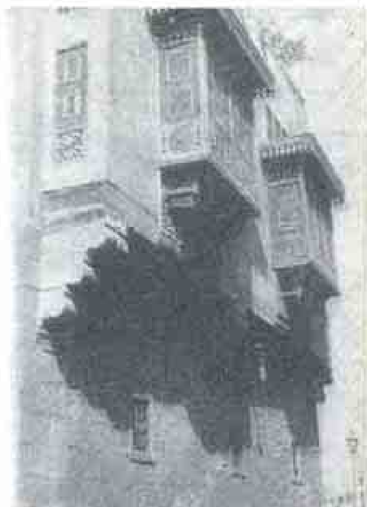
استمرار اليروزات في احد المباني السكنية القديمة بالقاهرة
