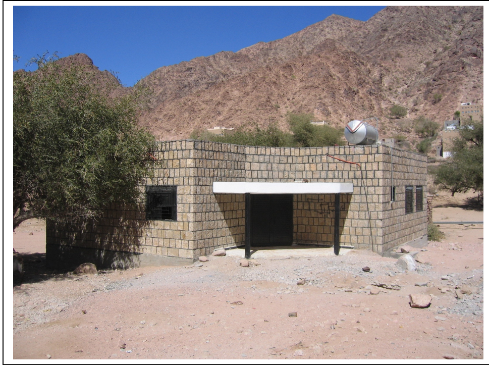
الشكل رقم 1-2: وحدة الشعبة الصحية، مديرية الصعيد، محافظة شبوة
